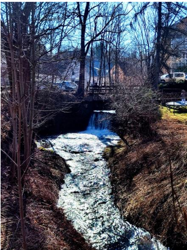
Stauwehr im Wuhrtal
